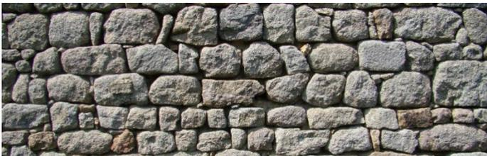
En règle générale, le matériau employé dans les murs extérieurs est laissé à l'état brut, naturel (*matériau d'épierrement*). Il peut être toutefois sommairement rectifié ou ébauché à coups de marteau. La pierre sèche ne fait l'objet d'une préparation plus soignée – équarrissage de moellons – que pour les murs d'habitations.
